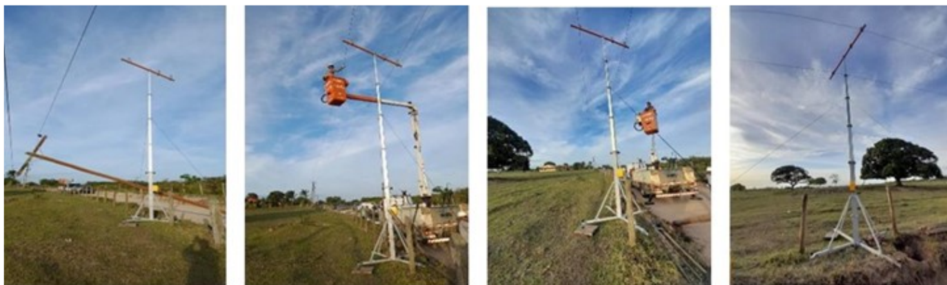
Fig. 10 Imagens das etapas da primeira utilização do Poste Telescópico Temporário em um atendimento real. Fonte: Autores
