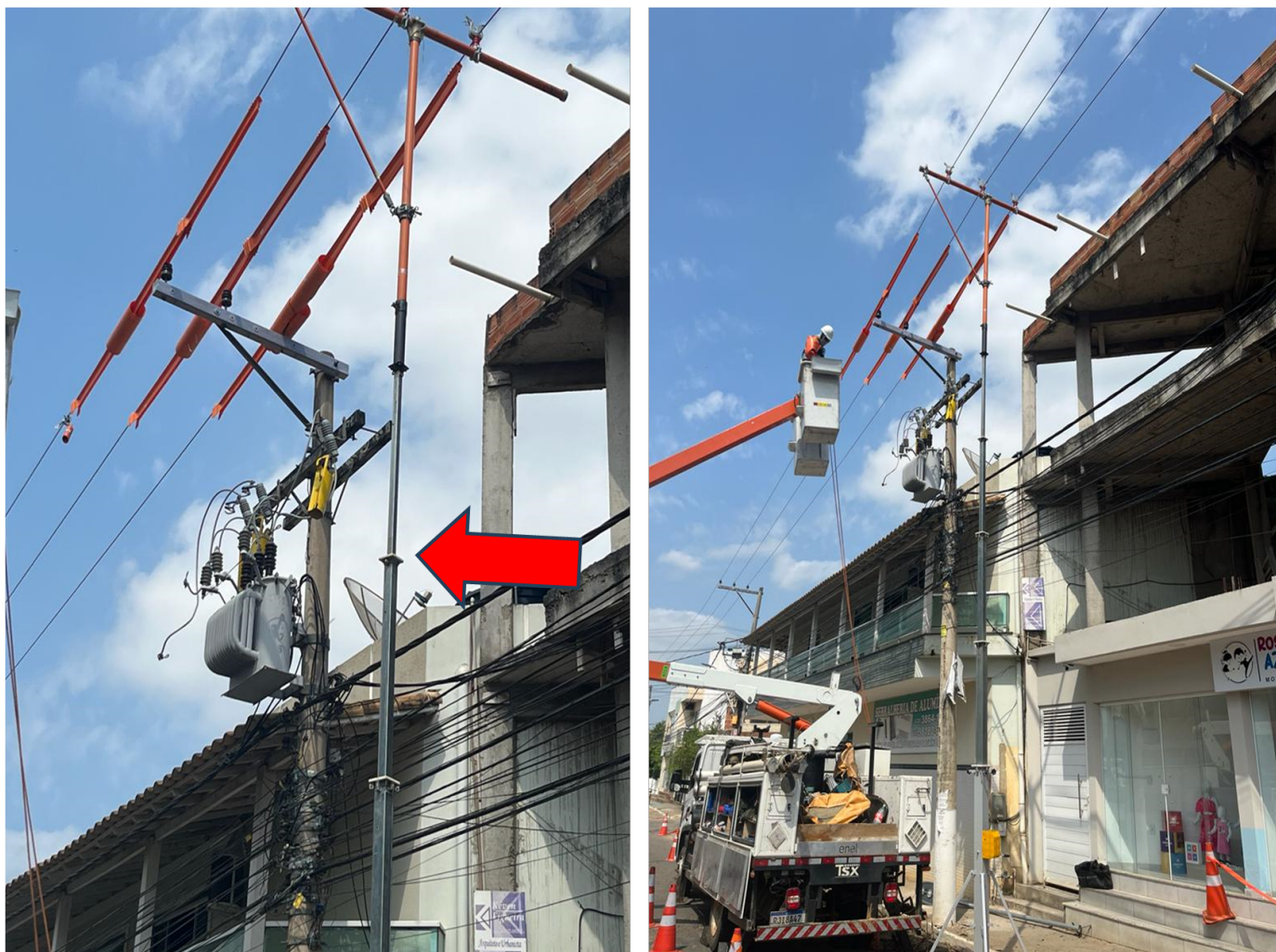
Fig. 12 utilização do Poste telescópico Temporário na substituição programada de uma cruzeta sem afetação aos clientes. Fonte: Autores
